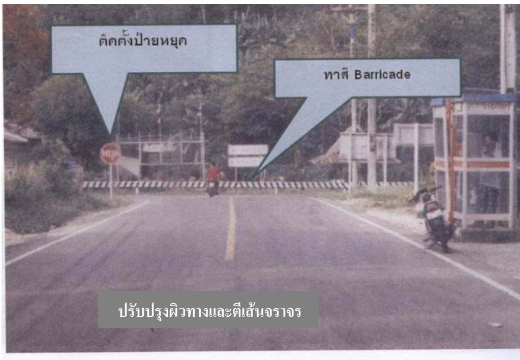
เปรียบเทียบสภาพถนนบริเวณทางแยกในชุมชน ก่อน – หลัง การปรับปรุง
