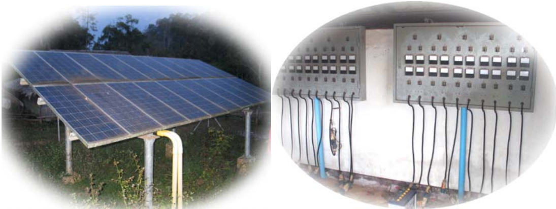
รูปที่ 2-5 ระบบประจุแบตเตอรี่ด้วยพลังงานแสงอาทิตย์แบบรวมศูนย์ ขนาดระบบ ละ 3 กิโลวัตต์ดำเนินการโดยกรมพัฒนาพลังงาน กระทรวงวิทยาศาสตร์ เทคโนโลยี และสิ่งแวดล้อม (เดิม) ติดตั้งปี พ.ศ. 2536-2540
