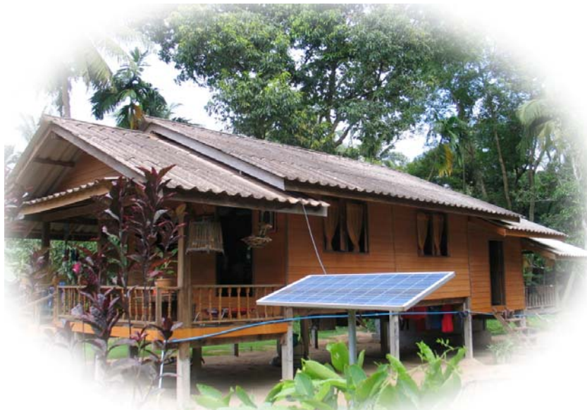
รูปที่ 2-11 ระบบผลิตไฟฟ้าสำหรับครัวเรือน (SHS) (ดำเนินโครงการโดยการไฟฟ้าส่วนภูมิภาค)
