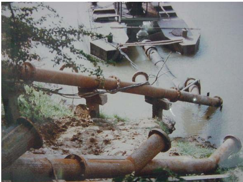
ภาพที่ 2.7 ลักษณะการติดตั้งเครื่องสูบน้ำบนแพ
