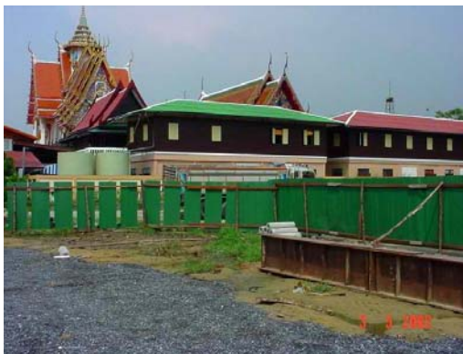
รูปที่ 4-1 ตัวอย่างรั้วกันเขตก่อสร้าง
