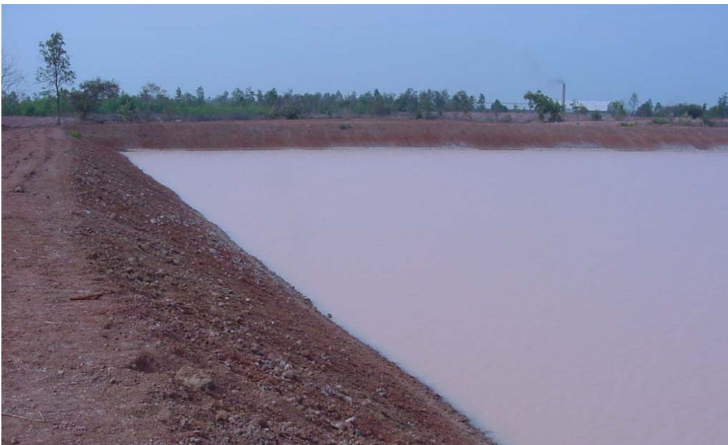
รูปที่ 2.2 แสดงคันดินหรือทำนบดินถมสระ
