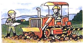
ทำการก่อสร้างบริการพื้นฐาน ได้แก่ ถนน ประปา ไฟฟ้า ระบบระบายน้ำ โทรศัพท์ ฯลฯ
